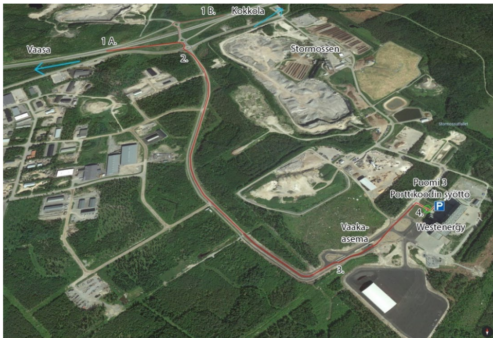
KUVA 1 Ajoreitti laitokselle (kohdat 1A/1B-4)
