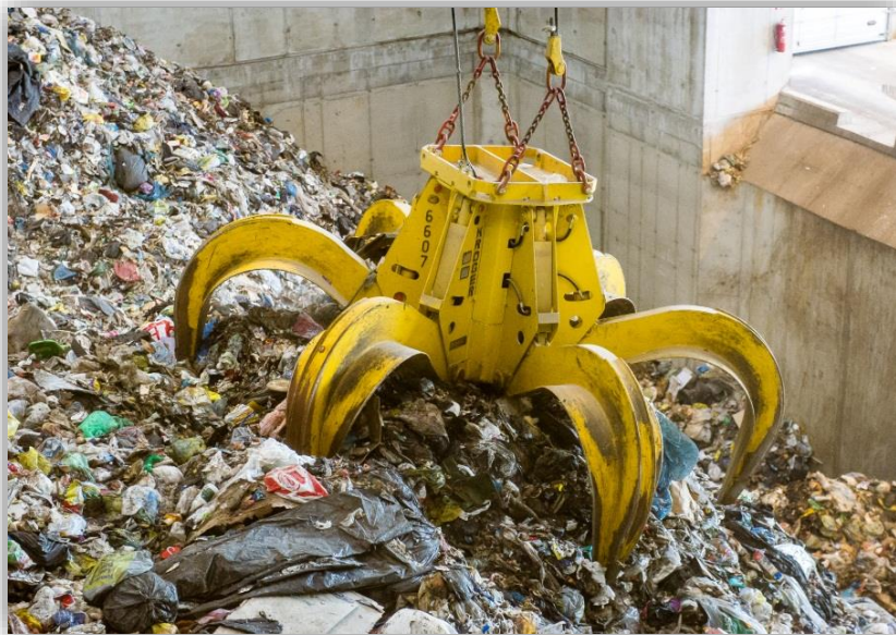
Kuva 2. Jätettä jätebunkkeriin syöttävä kahmari.
